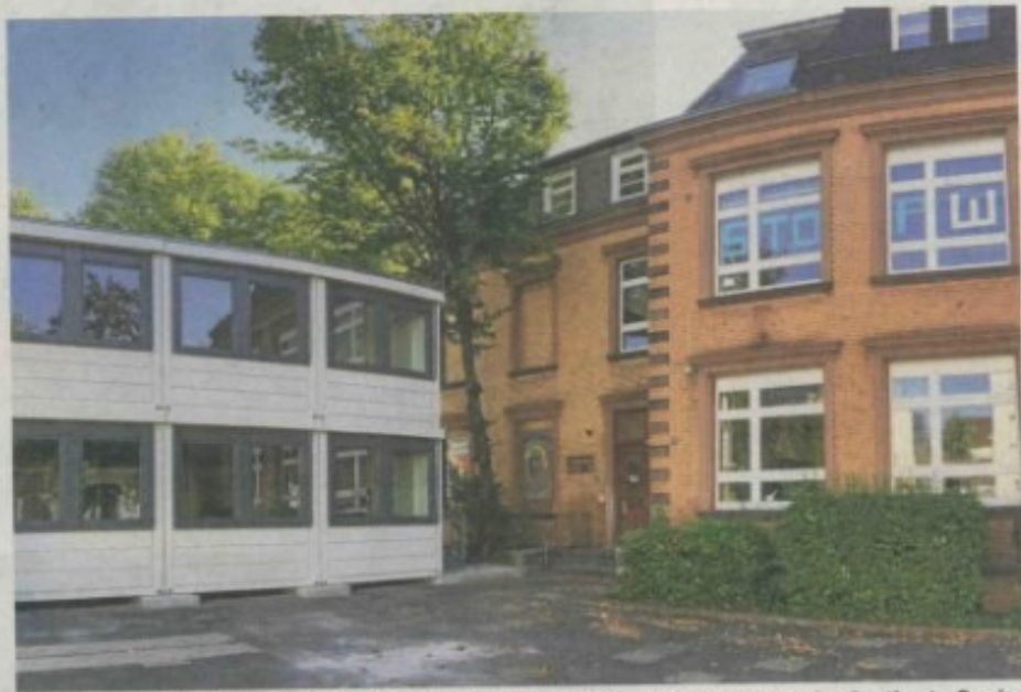
Schulkarussell: Die Neheimer Grimmeschule soll in die ehemalige Realschule an der Goethestraße ziehen. An den jetzigen Standort soll dann die Graf-Gottfried-Schule komplett und teilweise die gegenüberliegende Grundschule „Rote Schule“ wechseln.
